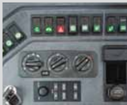
Panel de conmutación
